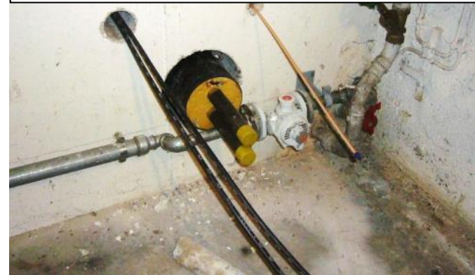
Hausanschlussleitung mit Hauseinführung innen
