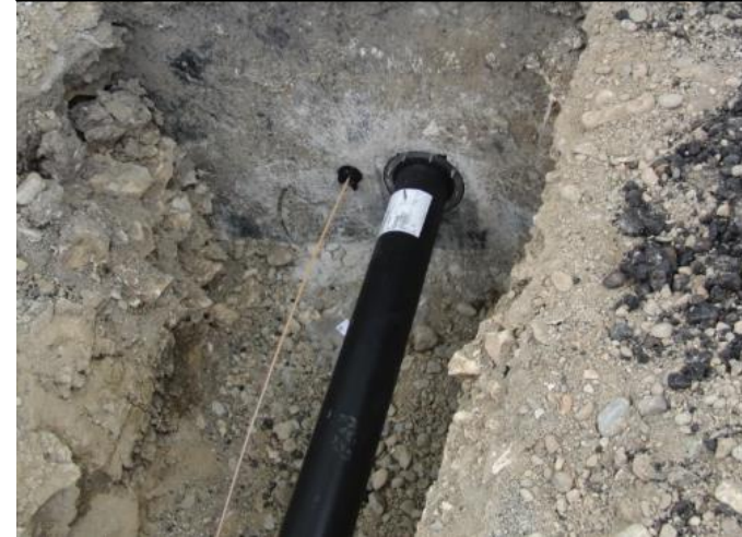
Hausanschlussleitung mit Hauseinführung innen
