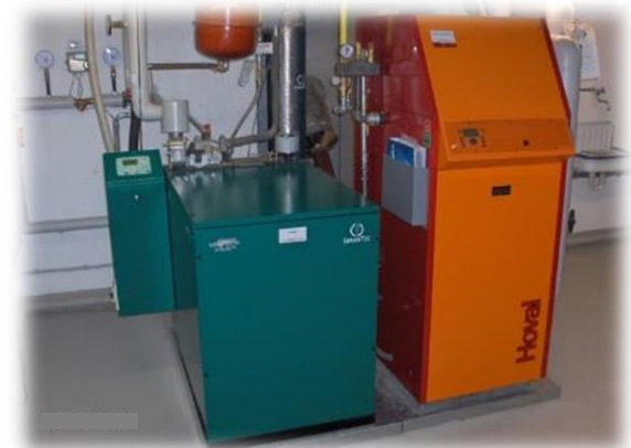
Blockheizkraftwerk
